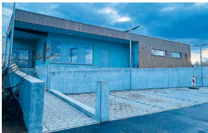
Anbau Kindergarten Rosenberg
