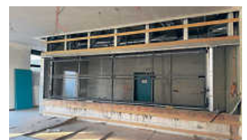
Die Trockenbauarbeiten im HGÖ gehen nach Verzögerungen im letzten Jahr nun zügig voran Foto: Stadt Öhringen
